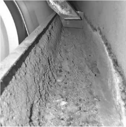
洗浄水を回収できておらず、セーブオール内が乾いている
