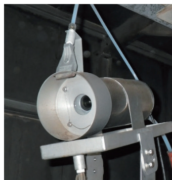
ドライヤーフード内に設置された耐熱カメラで 24 時間 365 日監視を行う
