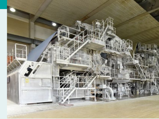
抄紙機(原料パルプから紙を製造する設備)
